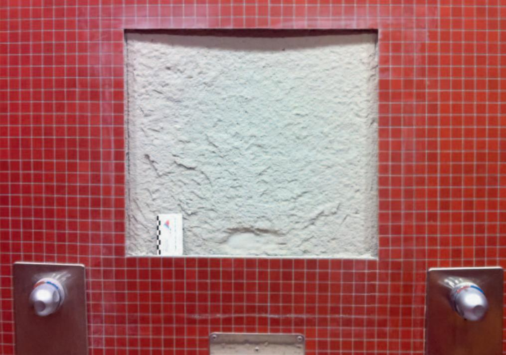
Ein Abriss im oberen Grundputzbereich: Zu sehen ist der zementäre Verlegemörtel, mit dem das Glasmosaik verlegt wurde.
