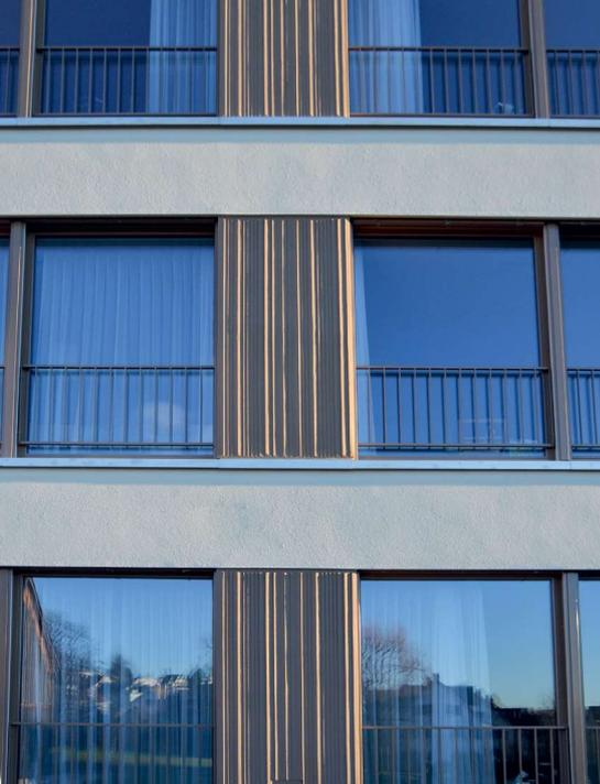
Die horizontalen Bereiche mit normalem Abrieb zwischen den Geschossen erleichterten die Arbeit. Es musste nicht die ganze Fassade in einem Zug gezogen werden.
