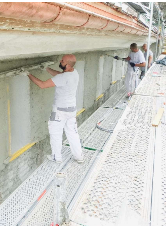
Lagenweises Auftragen nass in Nass und Verziehen des Dämmputzes.
