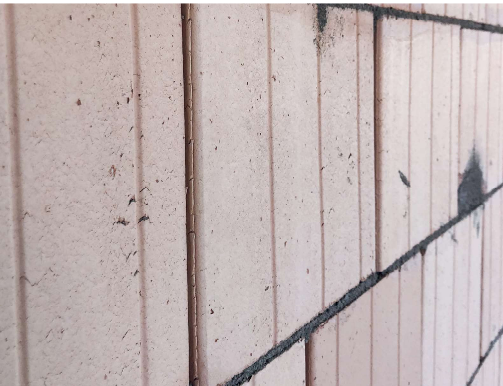
Einsteinauflage in der Sanierung.
