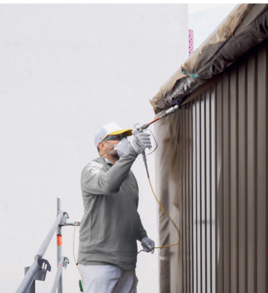
Für die Beschichtung eignen sich vor allem 2K-Systeme. (Bilder auf dieser Doppelseite: Sto AG)
