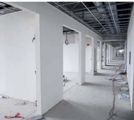
Für Tapezier- und Klebearbeiten auf massiven Gips-Wandbauplatten muss besonders die Art der Wand- und Deckenanschlüsse beachtet werden.
