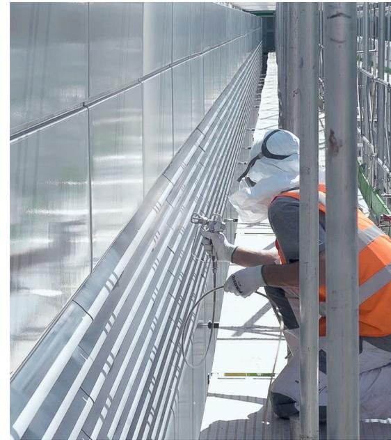
aufweicht. Nach der Reinigung wurde trocken geschliffen und anschliessend entstaubt sowie abgespült.
