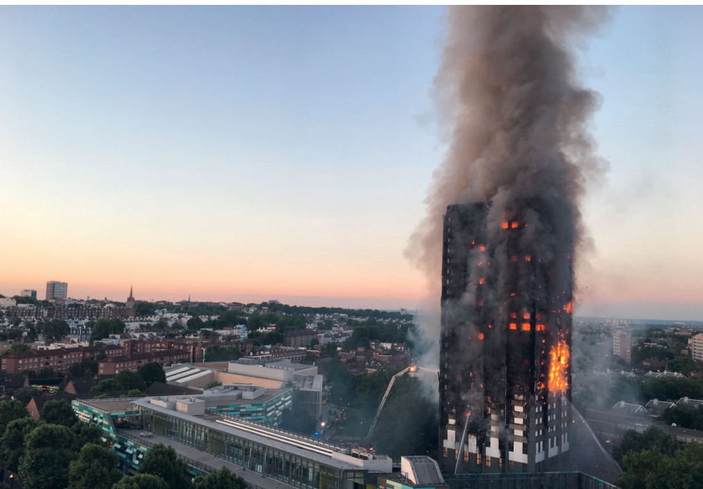
Die leicht entzündliche Gebäudeverkleidung des Londoner Grenfell-Towers fungierte quasi als Brandbeschleuniger. (Quelle: «Die Zeit» online). (Bild: Natalie Oxford)
