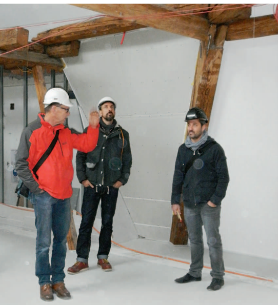
Im Dachgeschoss der Bürgerbibliothek werden die Handwerksarbeiten genau unter die Lupe genommen. (Bild: Walo Britschgi)
