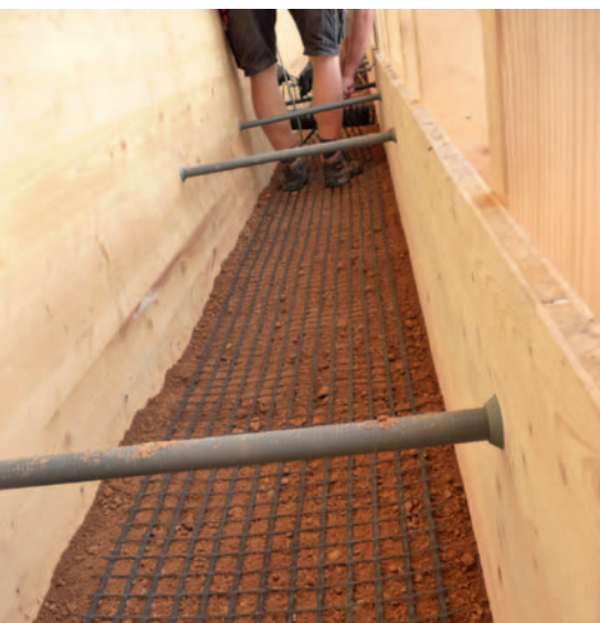
Mehr als ein Kilometer Geotextil wird eingestampft.
