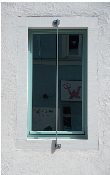
Bild oben: Die Sandsteingewände im EG wurden flächenbündig direkt angeputzt und in der Putzfarbe überstrichen.
