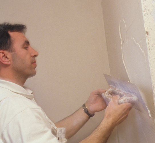
Gipseraltag: Der Abrieb wird mit der Traufel aufgezogen...
