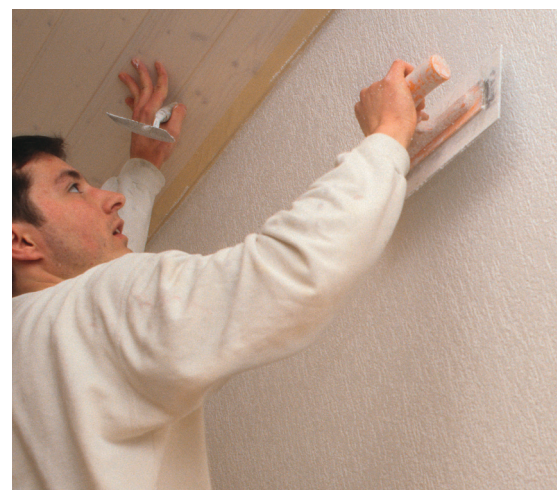
... und anschliessend mit der Reibscheibe strukturiert. (Bilder: SMGV)
