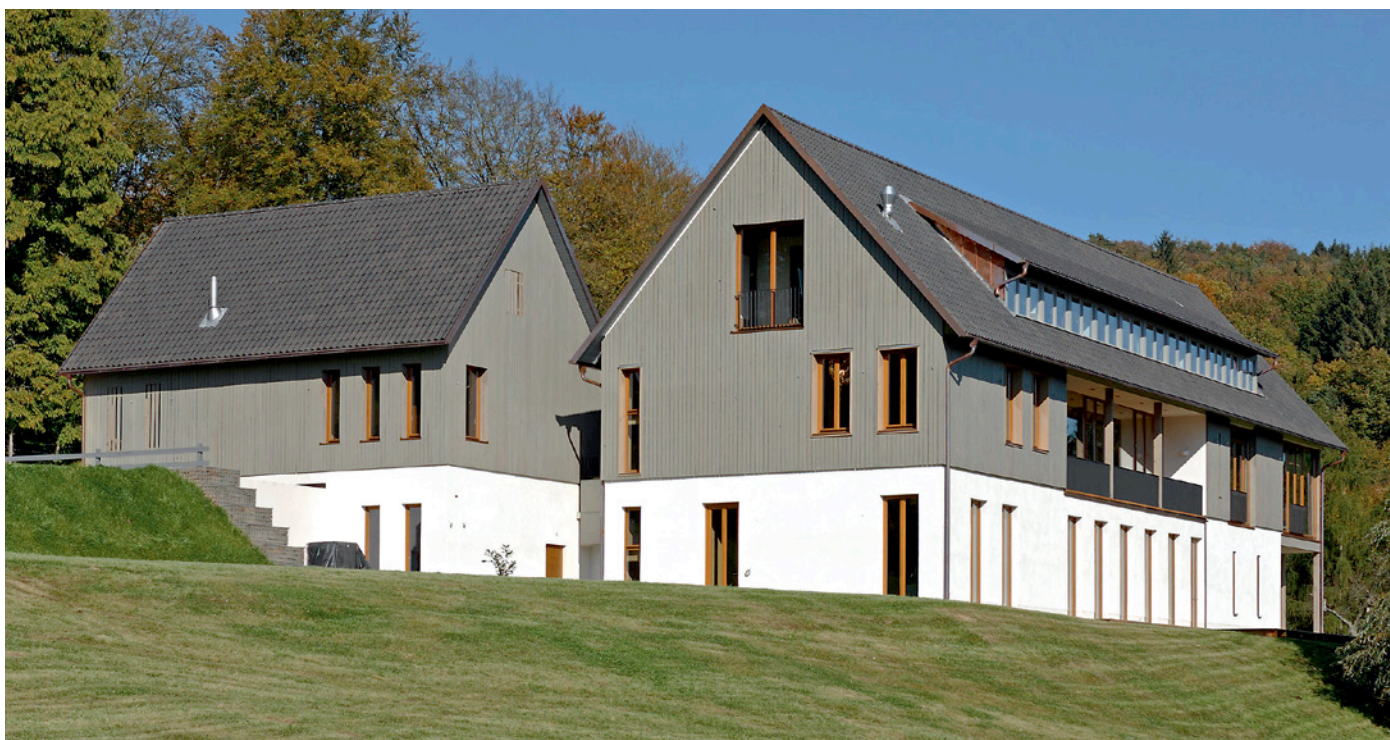
Oft sind Holzkonstruktionen mit einem WDVS versehen – hier der Sockel des Ecolut Centers im deutschen-Engelskirchen. (Bild: Claytec/Koculak)
