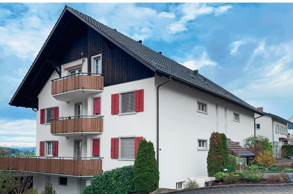
In Brütten ZH steht dieses Mehrfamilienhaus, dessen Fassade vor rund 25 Jahren mit Kork gedämmt worden und bis heute schadenfrei geblieben ist. (Bild: Stroba)
