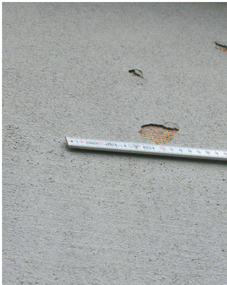
Bild 2: Hagelschaden oder nicht?
