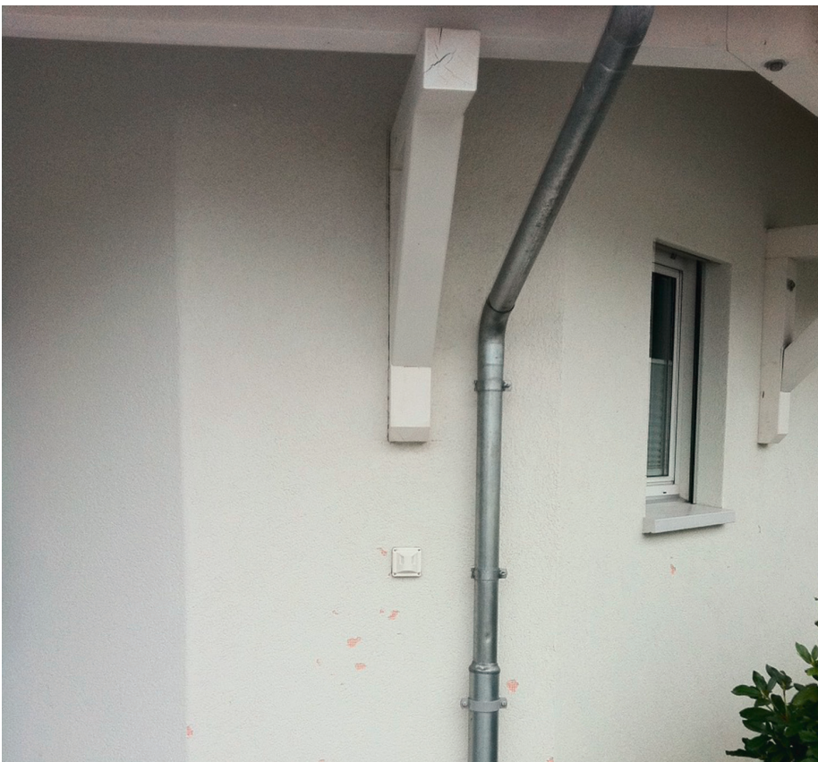
Bild 17: Gut geschützte Fassade.
