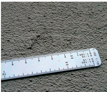
Bild 6: Leichte Hageldelle mit Riss.
