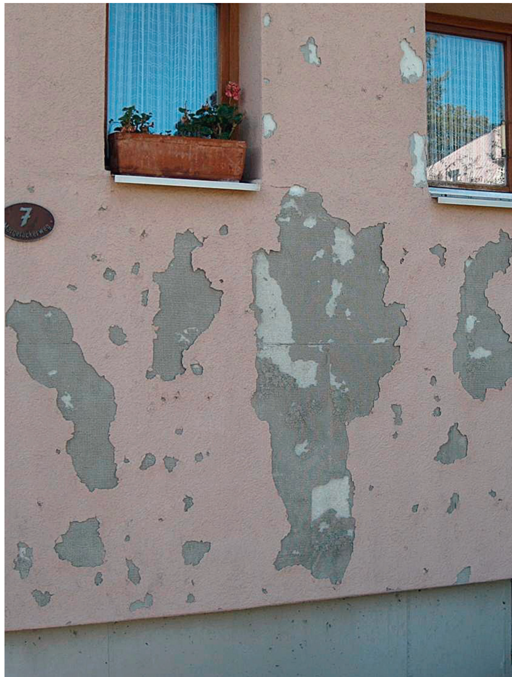
Bild 3: Kein eindeutiger Hagelschaden.
