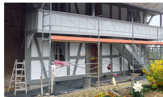
... und nach der Renovation. (Bilder: Agitec AG)
