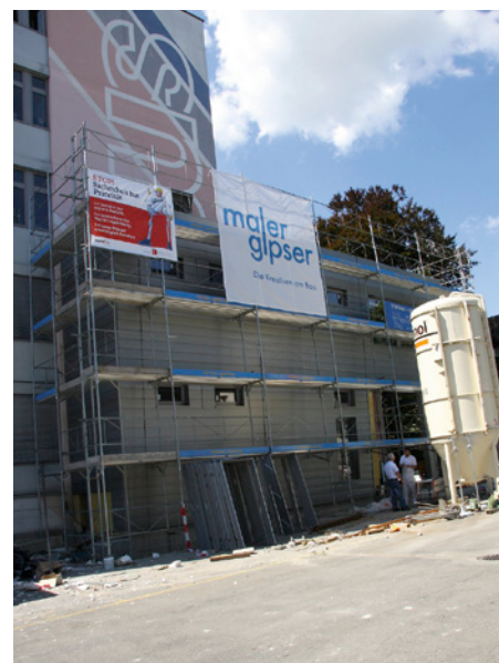
Arbeitsleistungen, die zum Eintrag eines Bauhandwerkerpfandrechts berechtigen, sind seit dem 1. Januar 2012 massgefertigte Baugerüste. (Bild: Cornelia Sigrist)
